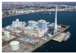
JPOWER 梶子火力発電所 (石炭火力発電所として 世界最高水準の発電効率と環境保全対策を実現)
